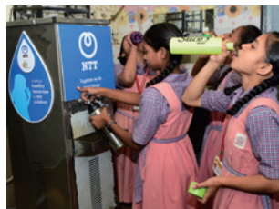
冷却機能付き浄水器を設置し、安全な 飲料水を提供
