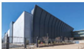
NTTデータ三鷹データセンター EAST： 2025年度中にPPA・非化石証書等の 手法通じて使用電力を実質的な再生可 能エネルギー100%に転換予定
