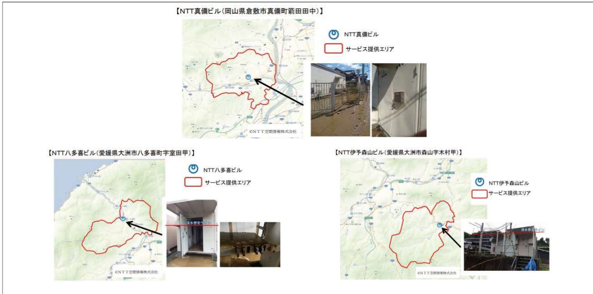
図表1-5-33 ▶平成30年7月豪雨：甚大な被害を受けた通信ビル
