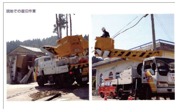
図表1-5-9 ▶新潟中越地震：現地での復旧作業
